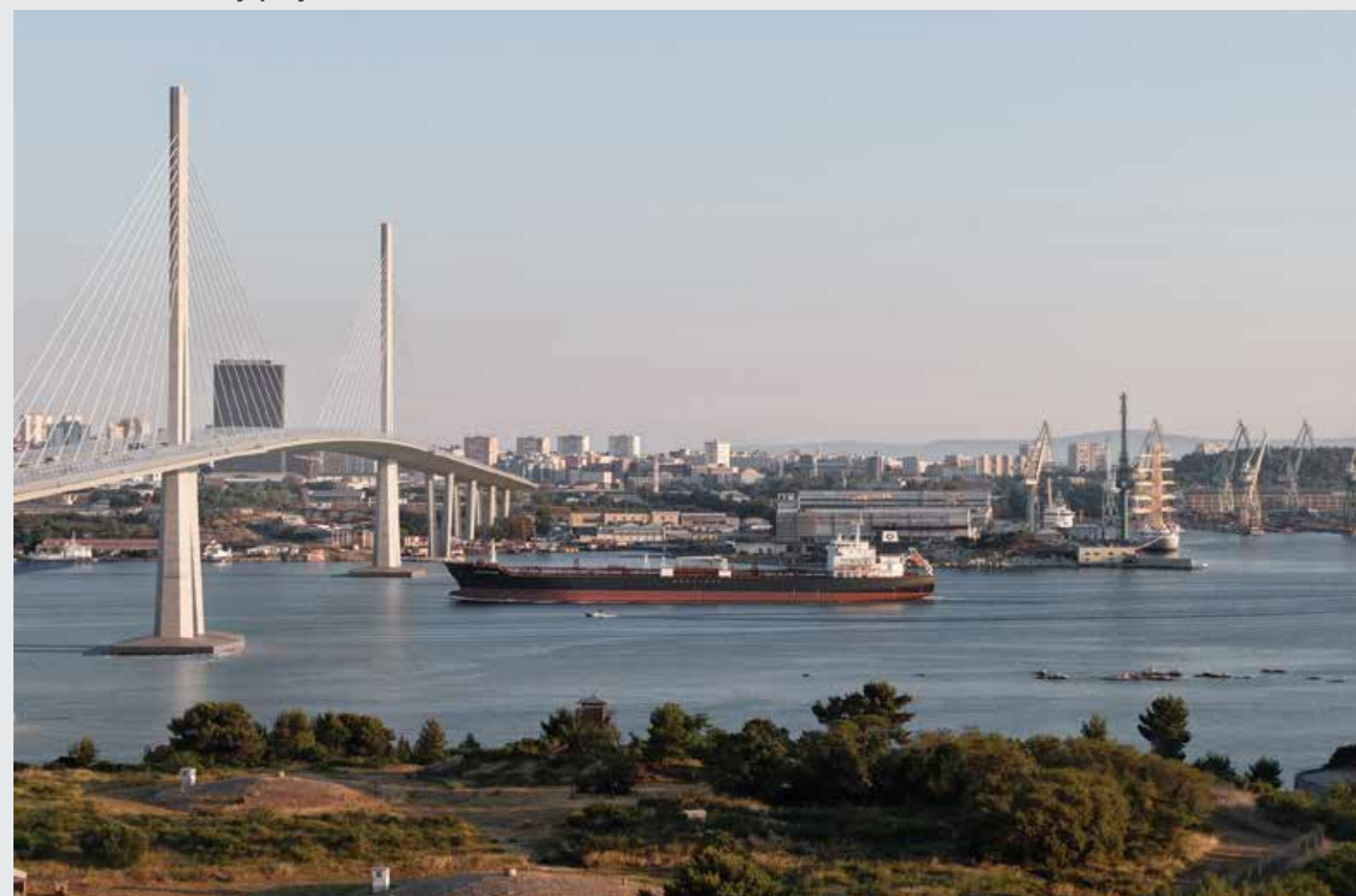
Podatki o mostu: dolžina mosta 1604 m, širina mosta 36 m, glavni razpon dolžine 400 m
