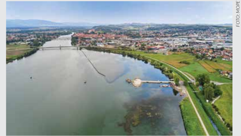
Recikliranje izkopenega sedimenta na Ptujskem jezeru.
