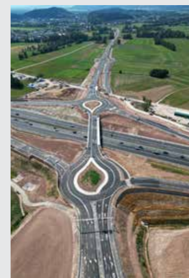
Novi avtocestni priključek Dragomer je kompleksni infrastrukturni projekt.
