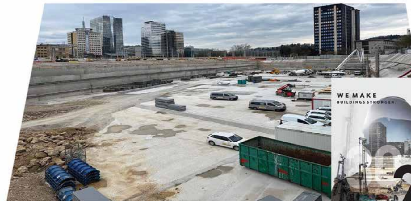
Zaščita izkopa gradbene jame EMONIKA SEVER
