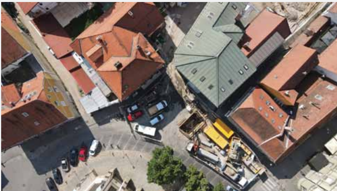
Primer izgradnje kanalizacije v centru mesta brez velikih posegov (gradnja na globini 4 metrov).
