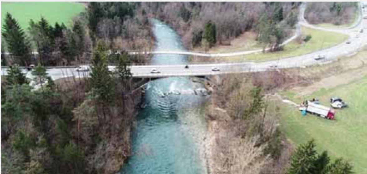
Izgradnja visokonapetostnega kablovoda pod reko Savo brez posega v samo reko, obrečni del in okolje.
